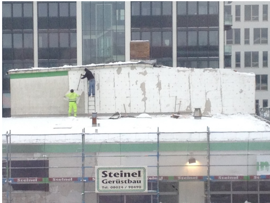
Bild 20: Beispiel für manuelles Entschichten von WDVS in der Praxis; Rückbau eines Büro- und Werkstattgebäudes im Jahr 2013 in Gräfelfing.
