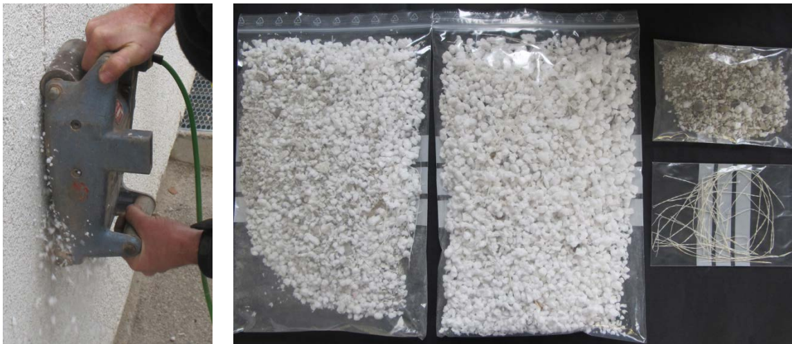
Bild 28: Abfräsen eines WDVS mit einer Handfräse (links) und die dabei erhaltenen Materialfraktionen (rechtes Bild von links nach rechts: Mischfraktion aus EPS und Putz, EPS, Putz, Gewebefasern).
