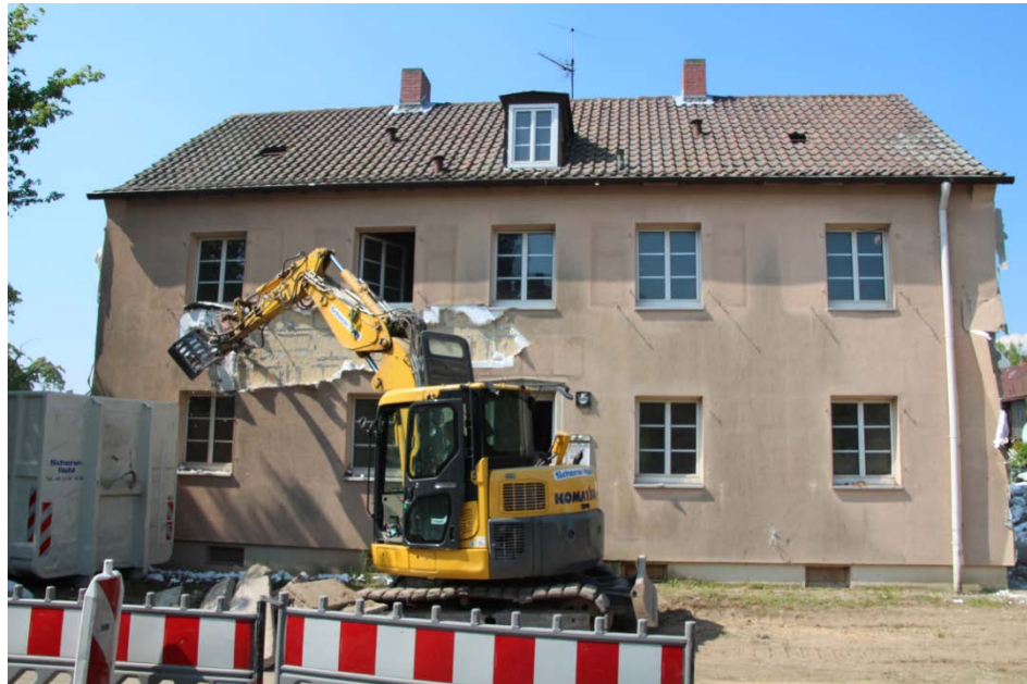
Bild 30: Rückbau eines Gebäudes (Ligustergang, Ludwigshafen).
