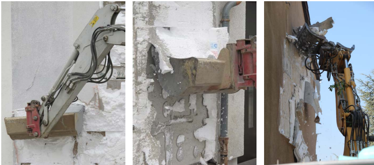
Bild 26: Selektives Abschälen der einzelnen Lagen im IBP-Versuch, Oberputz (links), Dämmstoff (Mitte) und teilselektives Abschälen in der Praxis (rechts).
