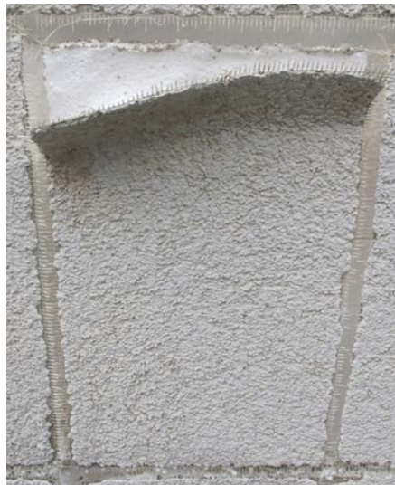
Bild 29: Beispiel für das thermische Entschichten vom Oberputz / Armierungsmörtel-Verbund.
