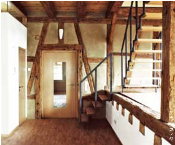
Umbau Fachwerkscheune zu Büroräumen in Lottstetten-Balm, Architekt: Christian Kaiser, www.zekadesign.de
