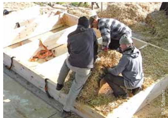
Ausfächung von vorgefertigten Holzbauelementen mit Strohballen ab einer Dicke von 40 cm
