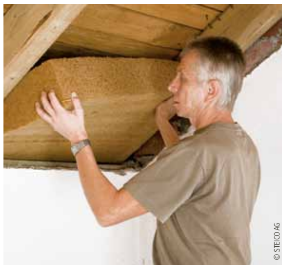
Einbringen einer flexiblen Dämmmatte
