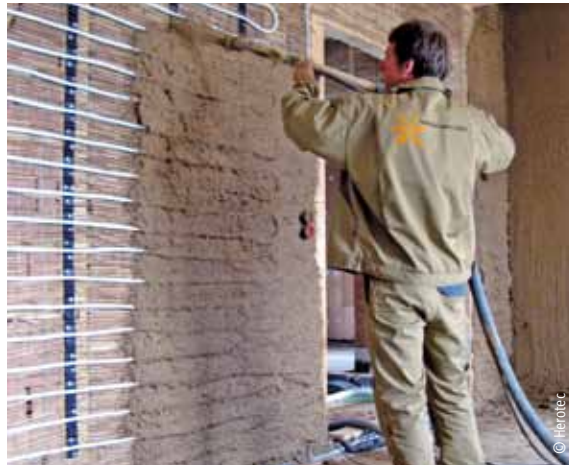
Aufspritzen des Lehm-Grundputzes auf ein frei verlegtes Rohrsystem
