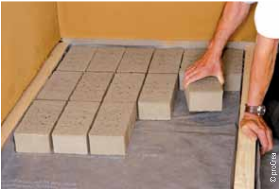
Einbau der Lehmsteine auf Rieselschutzmatte, Fugenbreite ca. 5 mm
