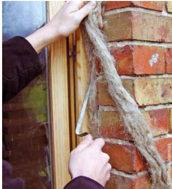
Ausstopfen von Bauteilfugen mit Hanf
