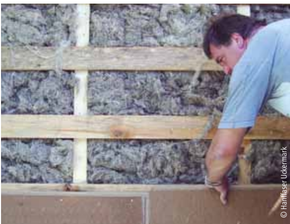
Innendämmung mit Hanfstopfwolle und verputzbarer Holzfaserplatte
