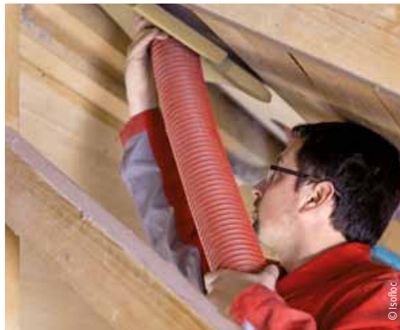
In einen vorbereiteten Dachhohlraum wird Zellulose eingeblasen.
