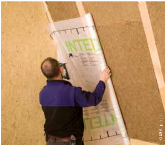
Raumseitiges Anbringen einer feuchteadaptiven („intelligenten“) Dampfbremse
