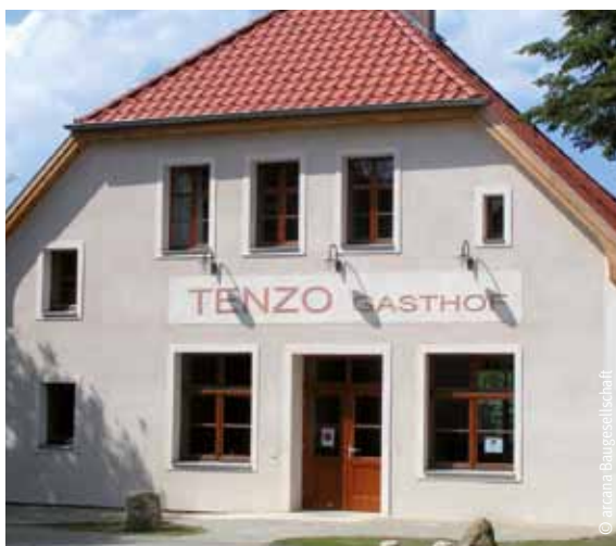
Mit reinem Kalkmörtel verputzte Fassade
