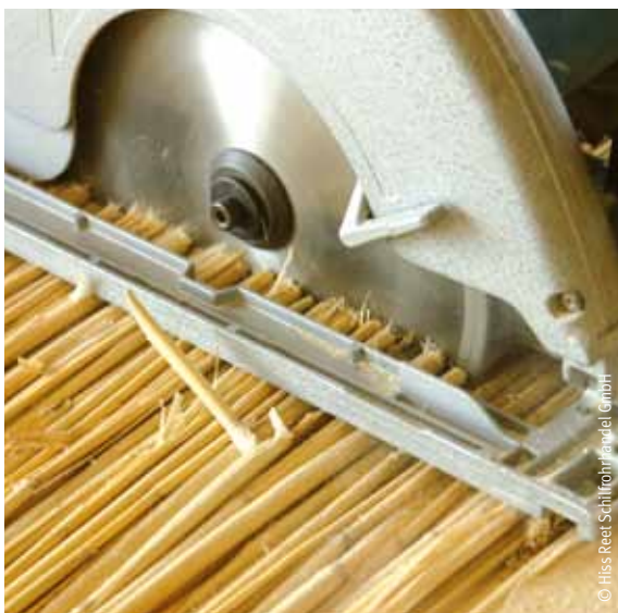
Zuschnitt von Schilfdämmplatten mit Handkreissäge
