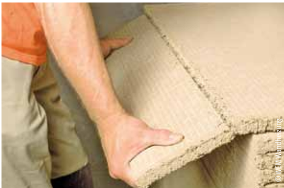
Ablängen einer Lehmbauplatte
