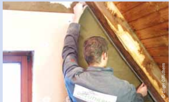
Komriband einlegen für Anschluss an Sparren.
