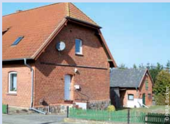
Ziegelsichtige Gebäudefassaden mit innenseitiger Dämmung
