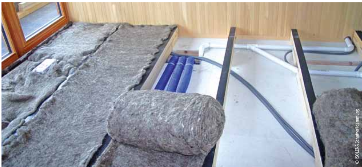
Fußbodendämmung mit Schafwollmatten
