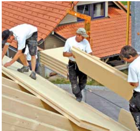
Wärmebrückenfreie Aufsparrendämmung mit wasserabweisenden Holzfaserdämmplatten
