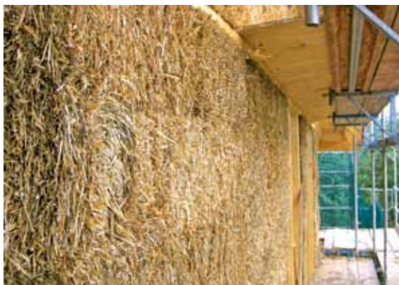
Stroh zwischen einer Holzrahmenkonstruktion (außen)
