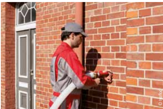
Nachträgliche Einblasdämmung bei zweischaligem Mauerwerk
