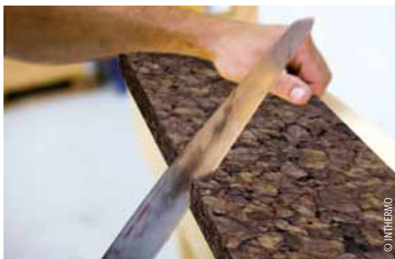
Einfacher Zuschnitt von Korkdämmplatten
