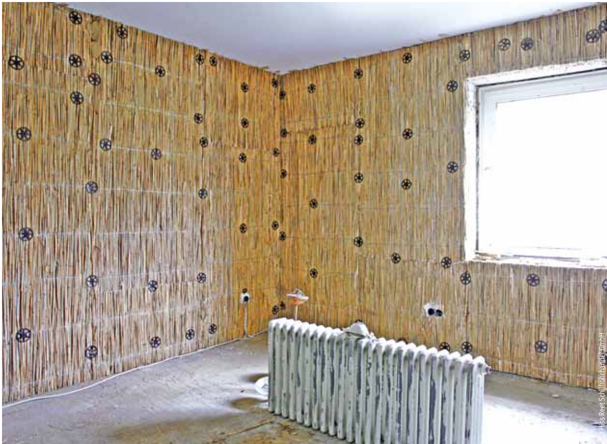
Innendämmung mit Schilfrohrdämmplatten
