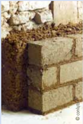
Wegen Reduzierung des Fugenanteils großformatige Steine bevorzugen.
