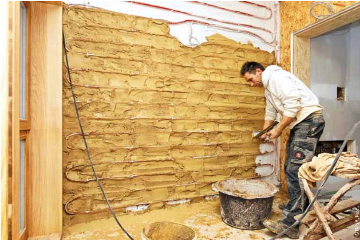
Lehmauftrag auf Wandheizung
