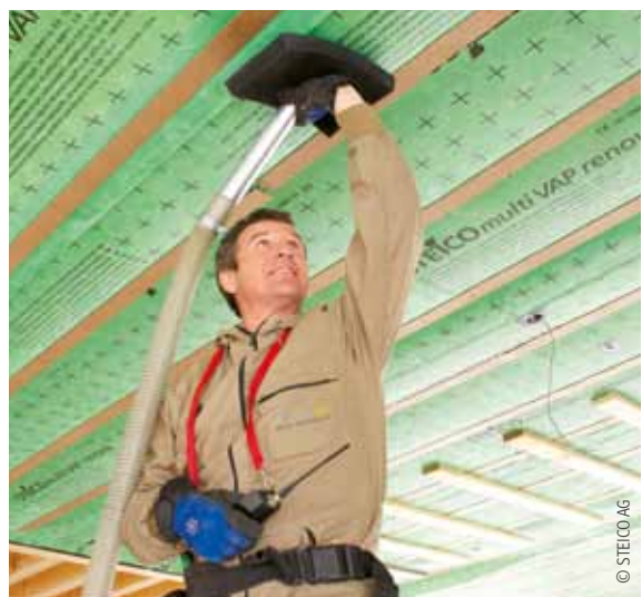
Dämmung der Zwischendecke mit Einblasdämmstoff
