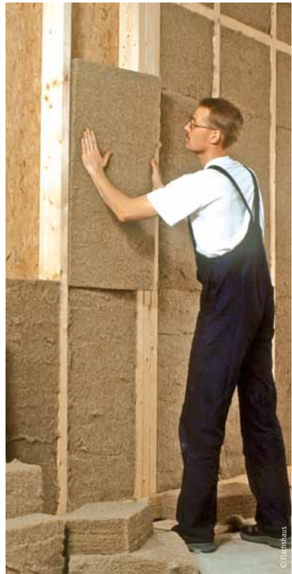
Ausfachung von Ständerwerk mit Flachsmatten
