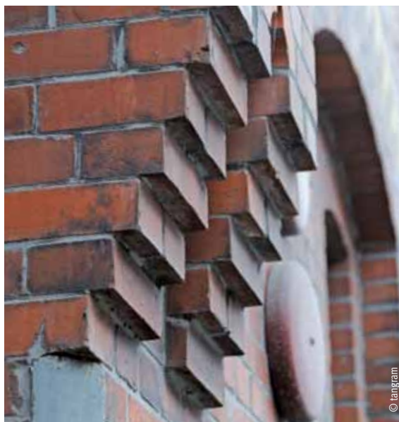
Detail eines Ziegelmauerwerks
