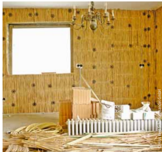
Mit Schilfplatten gedämmter Innenraum
