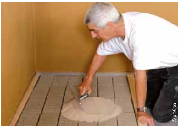
Auffüllen der Fugen mit Quarzsand
