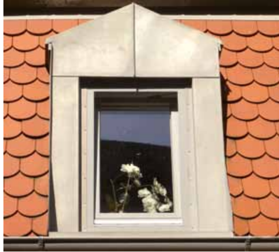
Gaubeneindeckung mit Edelstahlblech
