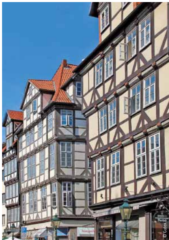
Außendämmung nicht möglich wegen denkmalgeschützter Fassade, zudem nicht genehmigungsfähig wegen Grundstücksüberbauung
