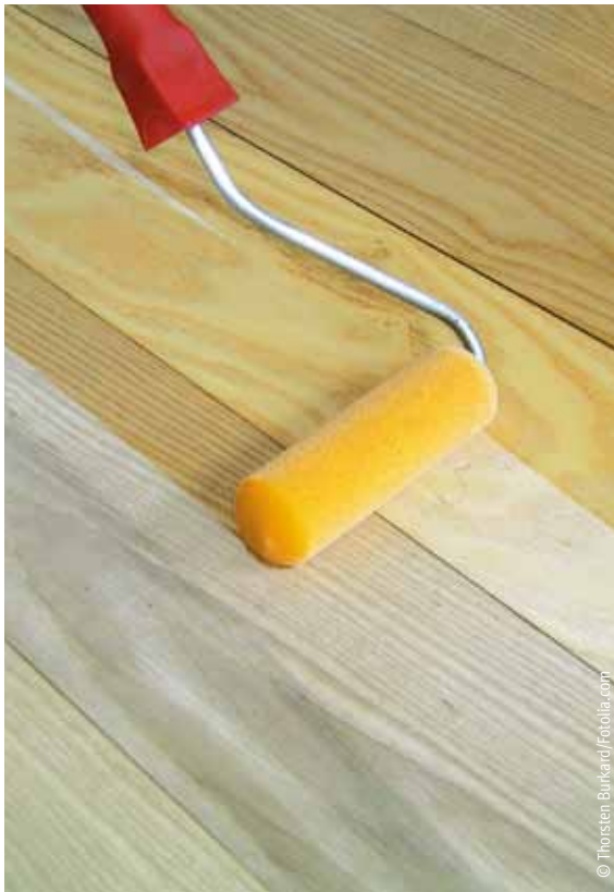
Auftrag von Fußbodenöl auf neuer Holzdielung
