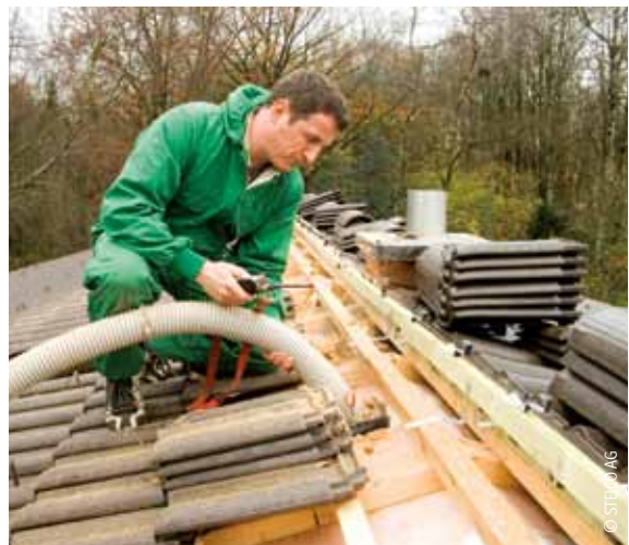
Einblasen von Dämmstoff
