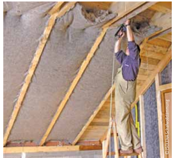
Dachdämmung mit Schafwollmatten
