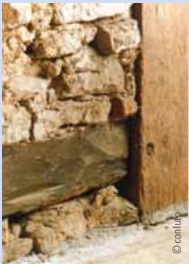
Lose und dampfsperrende Schichten von Wand entfernen. Wand gegebenenfalls trocknenlegen.
