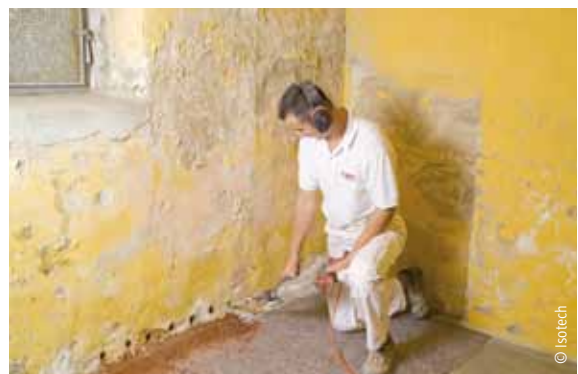
Vorbereitung zur Bohrlochtränkung
