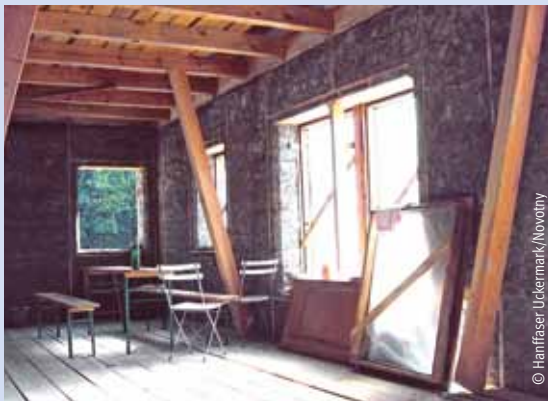
Hanfämmlehm als Innendämmung der Außenwand
