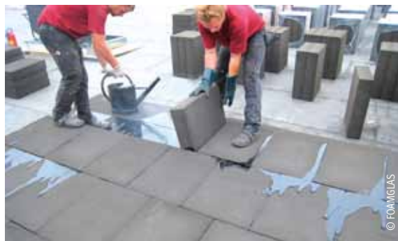
Verlegung von Glasschaumplatten
