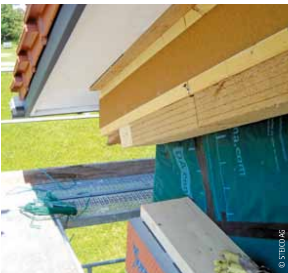
Detail einer Dachdeckung mit Holzfaserdämmung
