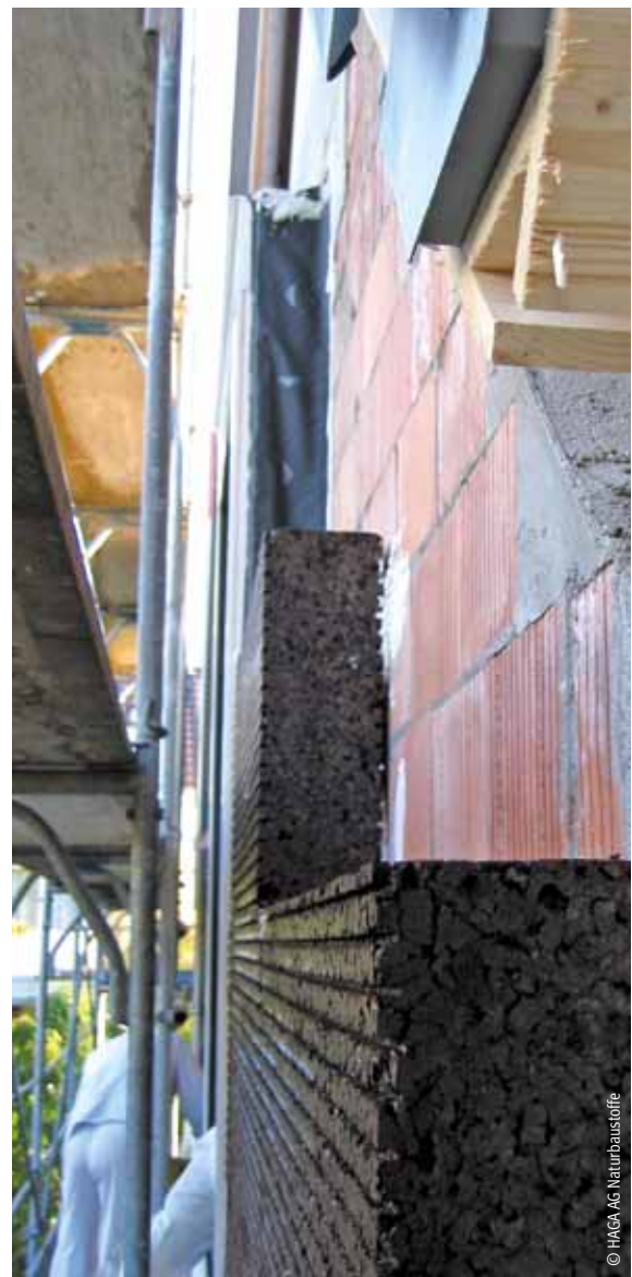
Korkdämmplatten als Fassadendämmung
