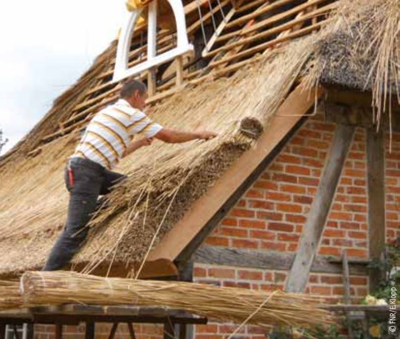
Reetdachdecker bei der Arbeit
