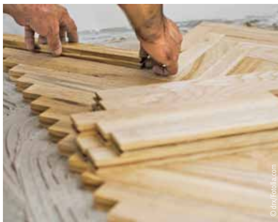
Verlegung von Stabparkett
