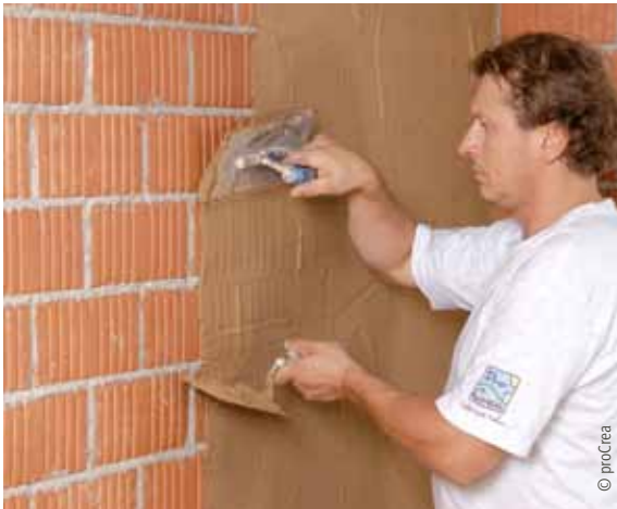
Auftrag des Grundputzes
