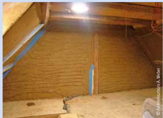
Einschlämmen der Heizrohre in Lehmgrundputz
