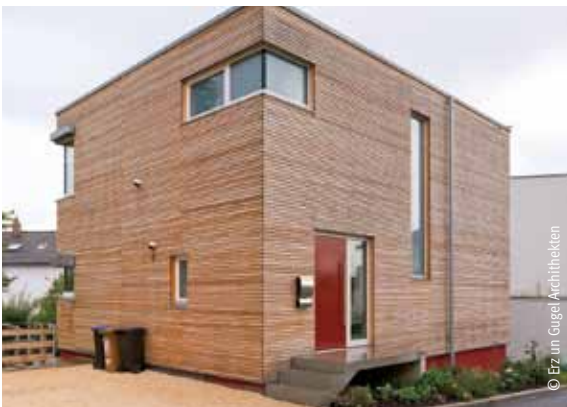
Waagrecht angeordnete Holzlamellenfassade an einem Neubau
