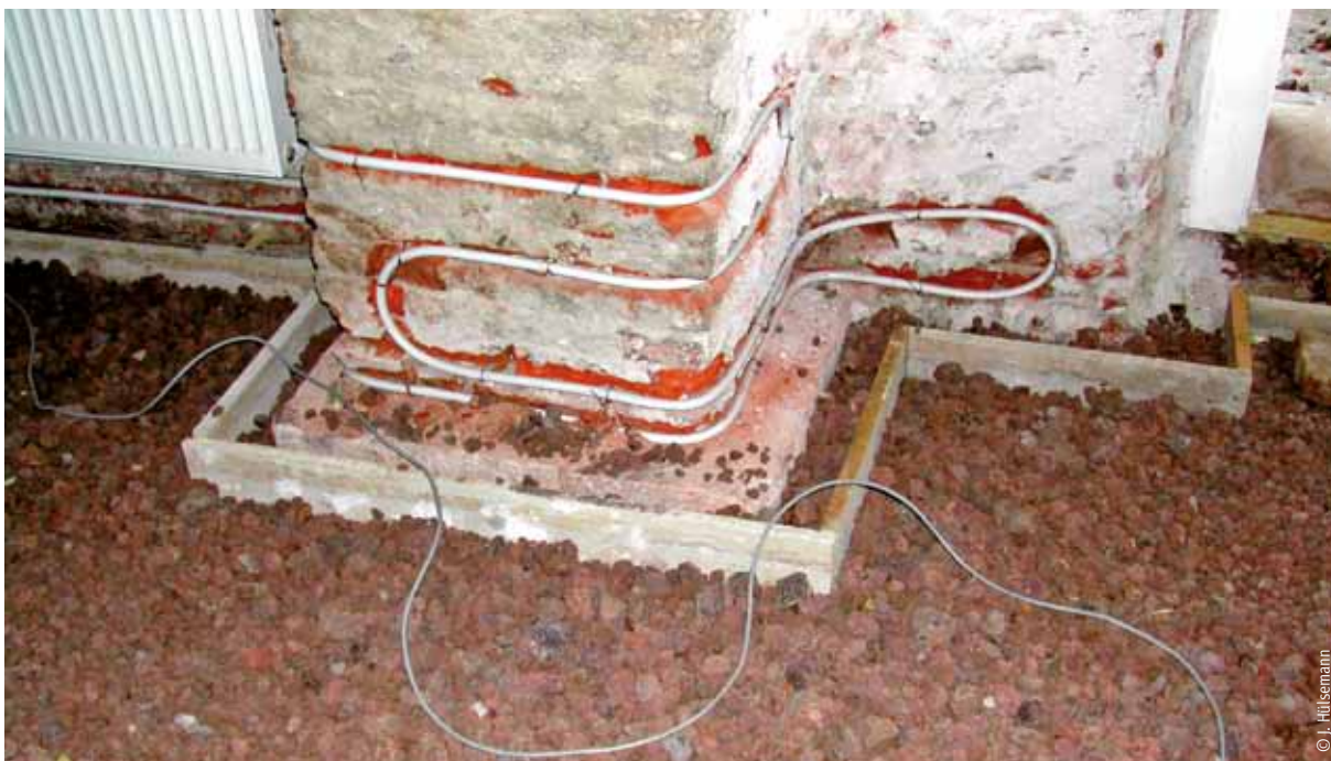
Bauteilheizung zur Trockenlegung von Außenwänden
