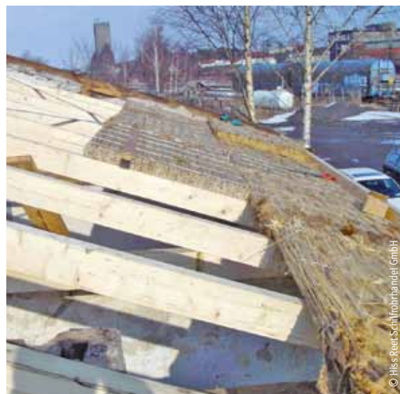
Aufdachdämmung mit Schilfrohrdämmplatten
