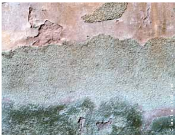
Schadhafte Putzoberfläche
