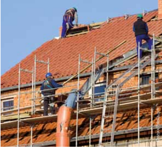
Dacheindeckung mit naturroten Falzziegeln
