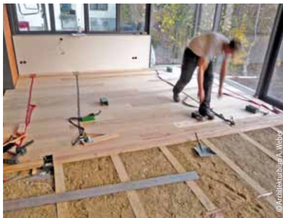
Ulmenmassivparkett auf Fußbodenheizung in Stampflehmbett
