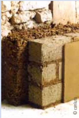
Mit dem Verputzen warten, bis Fugenmörtel augenscheinlich trocken ist. Lehmputz zweilagig mit Armierungsgewebe. Anstrich vorzugsweise mit Kalk-Kasein-Farbe.
