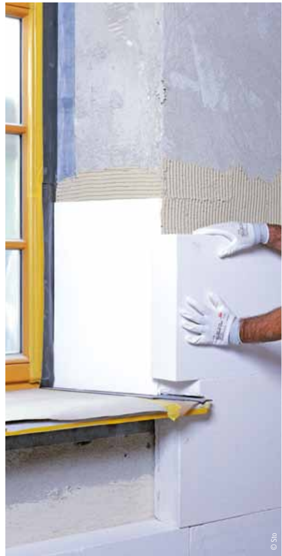
Innendämmung mit Perliteplatten
