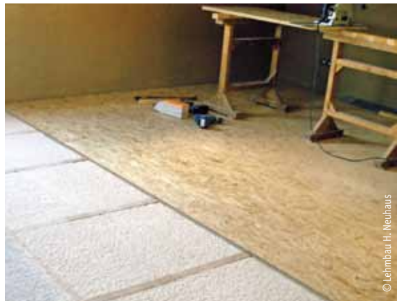
Hohlraumfüllung mit Perlite, Abdeckung mit OSB-Platten
