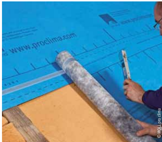
Befestigung einer Unterspannbahn auf der Außenseite der Sparren
