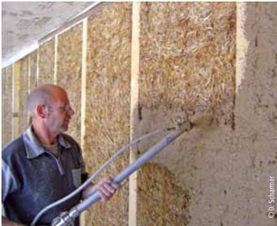
Aufbringen des Lehmputzes mittels Putzmaschine
