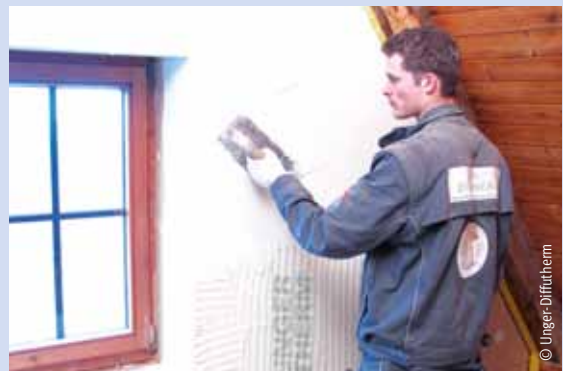
Armierungsgewebe in Kalk- oder Lehmputz einarbeiten.
