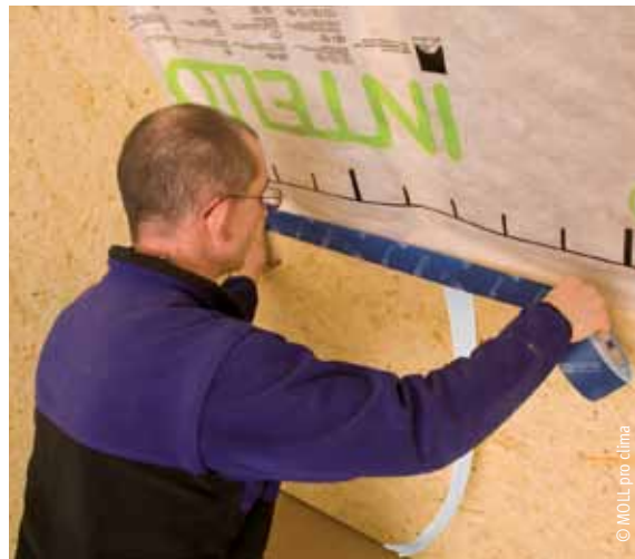
Anschluss an Drempelwand
