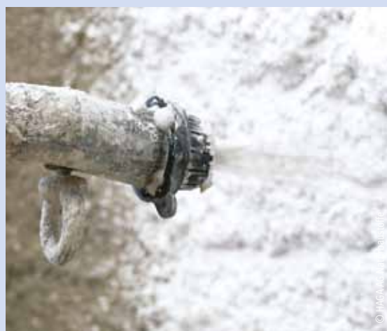
Aufbringen eines Wärmedämmputzes mittels Putzmaschine
