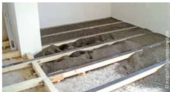
Auffüllen eines Hohlraumes mit Glasschaumschotter
