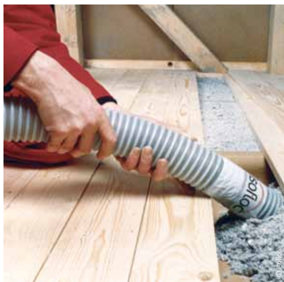
Einblasdämmung als Wärme- und Luftschalldämmung unter Fußböden
