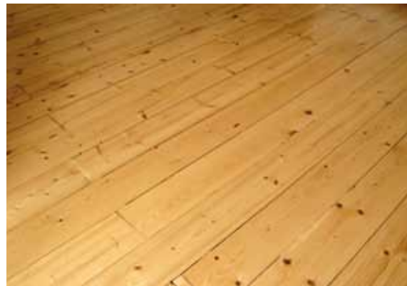
Dielenboden auf Lehmsteindecke
