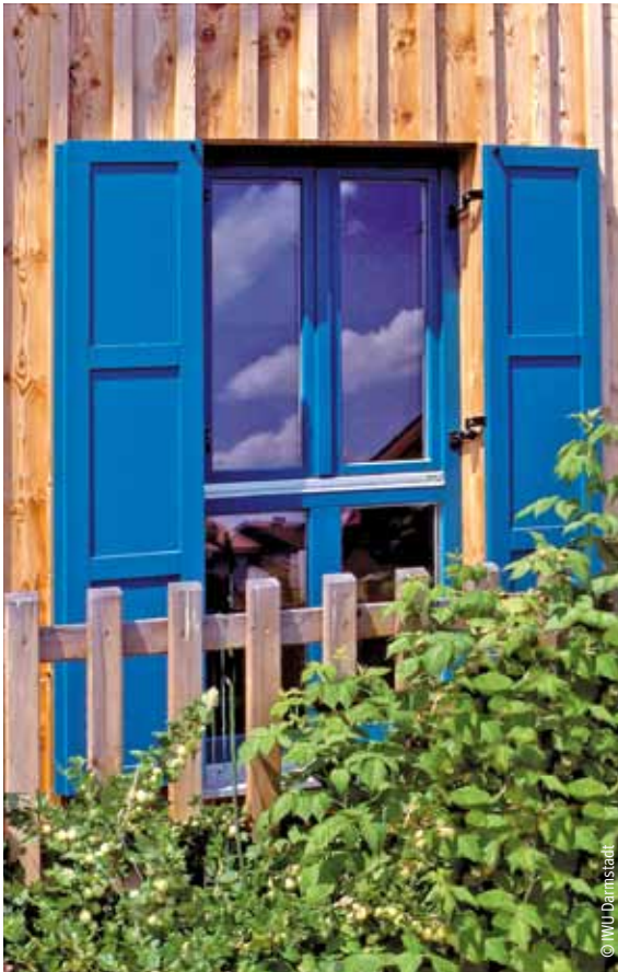
Farbige Akzente in naturbelassener Lärchenholzfassade, Fensterrahmen und Fensterläden deckend gestrichen
