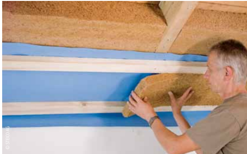
Ausfüllen der Installationsebene mit natürlichem Dämmstoff
