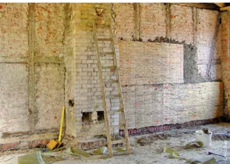
Innendämmung mit Schilfrohr-Dämmplatten
