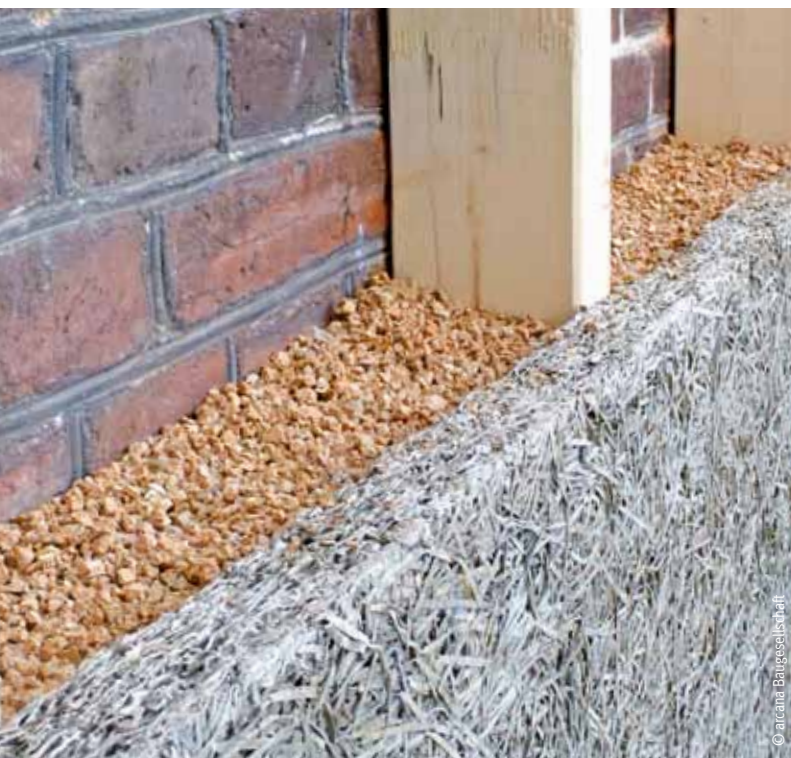
Außenwanddämmung: Korkschüttung mit Holzwolle-Dämmplatten auf Unterkonstruktion
