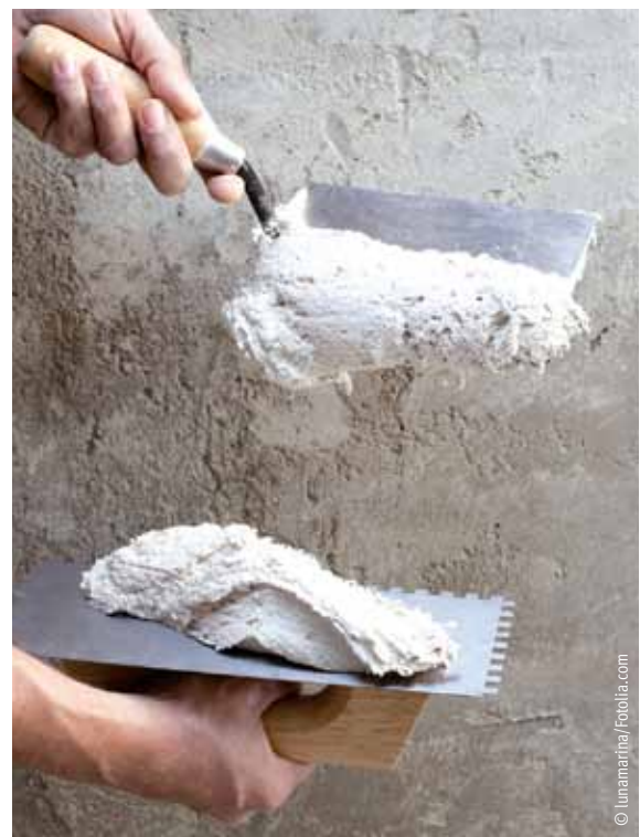
Gips wird mit einer Zahnkelle aufgetragen.
