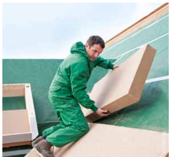
Aufbringen einer Aufsparrendämmung
