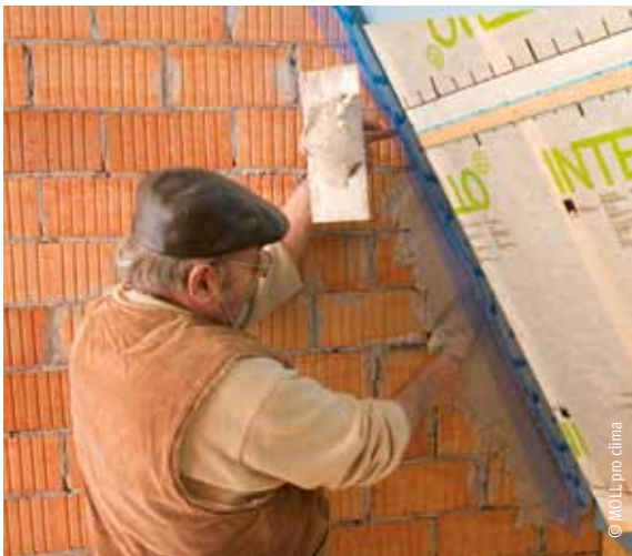
Einputzen des Dichtungsbandes
