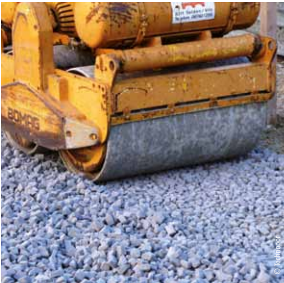
Schaumglasschotter als kapillarbrechende Wärmedämm- und Tragschicht
