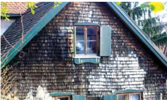
Verkleidung mit gesägten Holzschindeln
