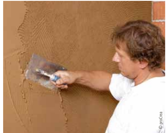
Auftrag des Oberputzes auf Grundputz
