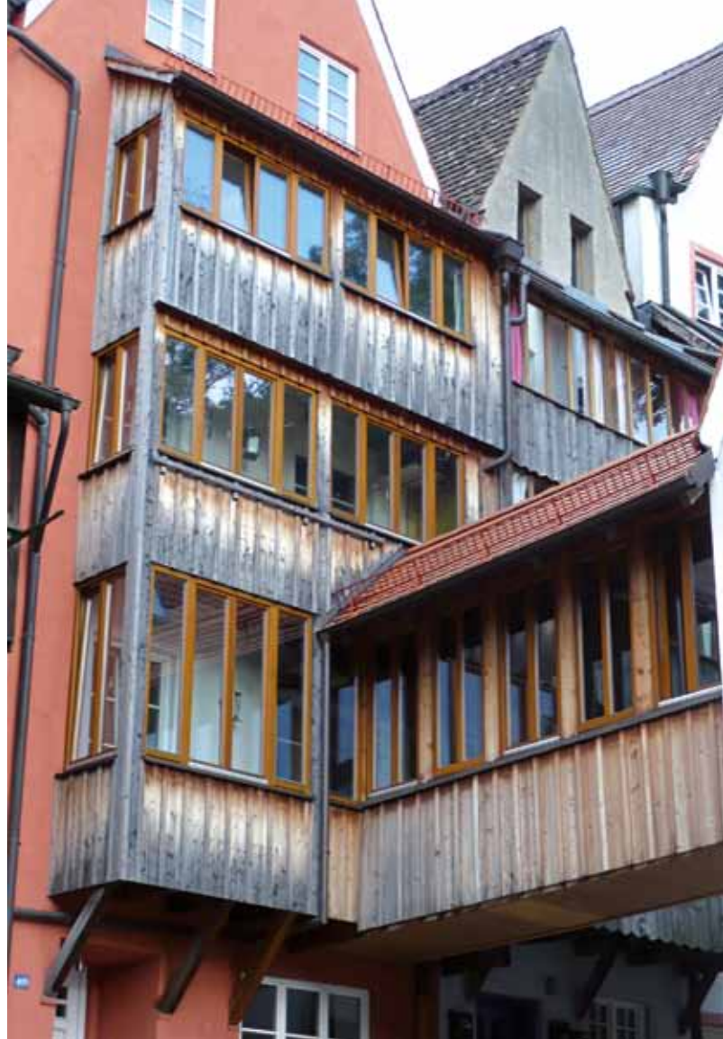
Unbehandelte Holzverschalung mit vertikal verlaufenden Brettern
