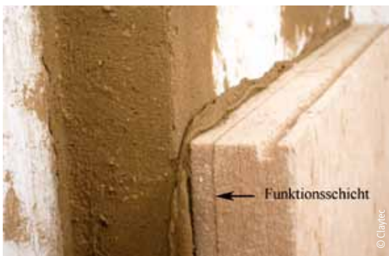
Befestigen der Holzfaserdämmplatte mit einem Lehm-Kleber. Deutlich erkennbar: Funktionsschicht im wandseitigen Drittel der Dämmplatte.
