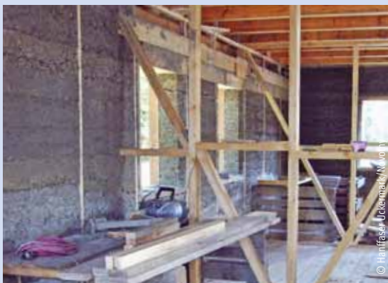
Mit Lehm verputzte Dämmebene
