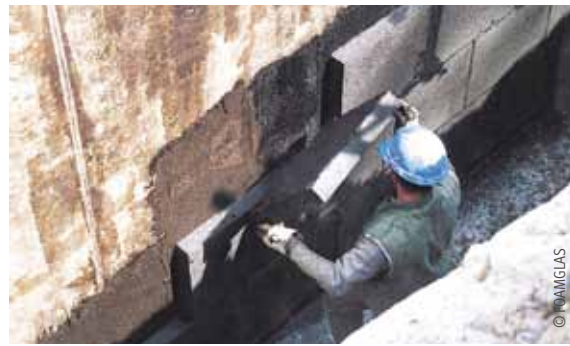
Befestigung von Glasschaumplatten an der Außenwand
