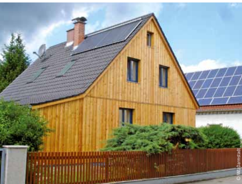
Holzfassade mit Boden-Deckel-Schalung
