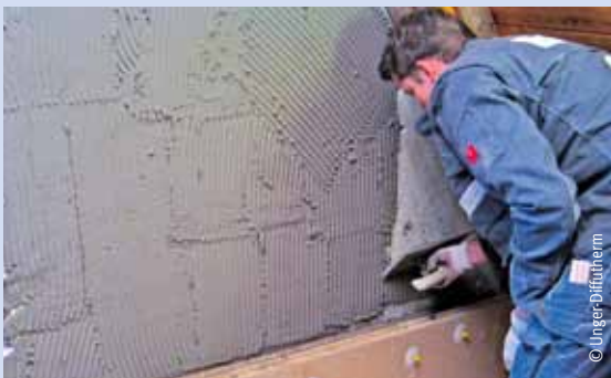
Lehmmörtel vollflächig mit Zahnkelle auftragen.
