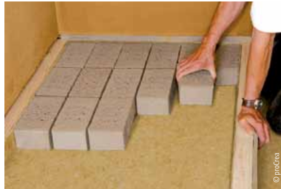
Einbau der Lehmsteine auf Hanffilzmatte (= schalltechnische Verbesserung)
