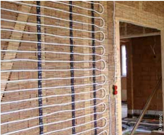
Wandheizung auf Schilfrohrmatten
