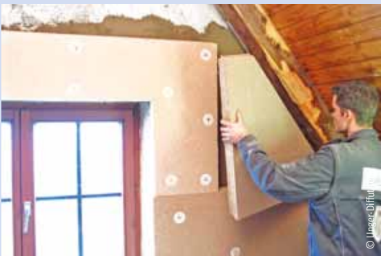
Dämmplatte stumpf an Balken stoßen.
