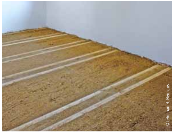
Hohlraumfüllung mit Lehm-Trockenschüttung
