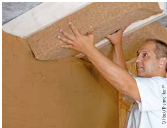
Dachdämmung mit Hanffasermatten
