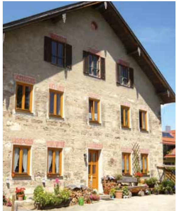
Mauerwerk aus Tuffstein, Fenster- und Türstürze aus gebranntem Ziegel
