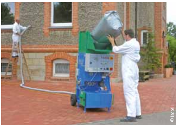
Befüllen der Zellulosemaschine
